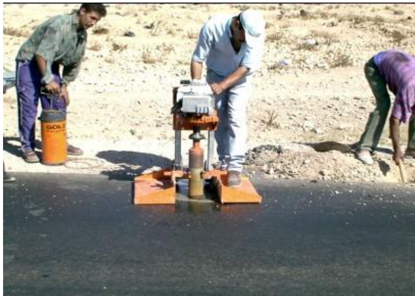
Vue montrant le carottage d'une couche d'enrobé
