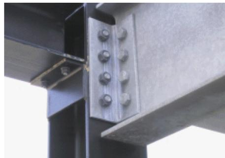
FIGURE 2.36 – Liaisons entre les IPE réalisant des articulations (liaisons rotules)
