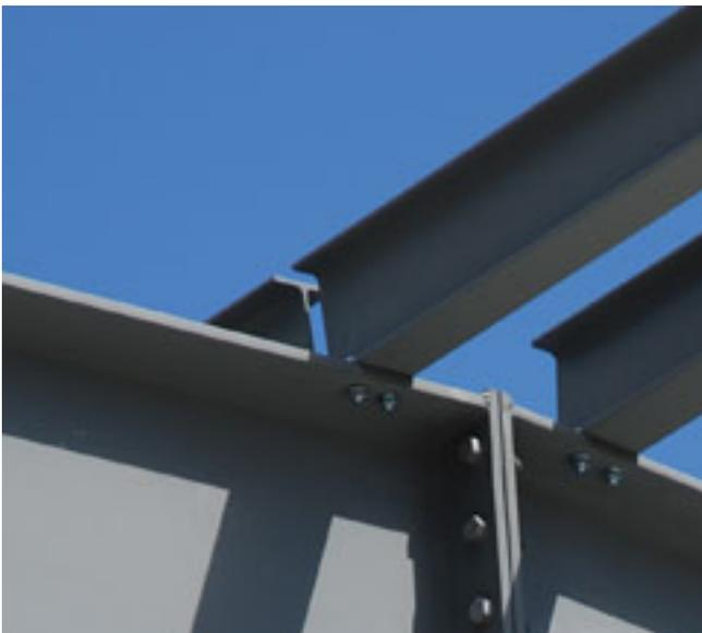
FIGURE 2.32 – Poutres IPE en appui simple si les trous sont oblongs
