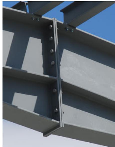
FIGURE 2.47 – Encastrement entre deux arbalétriers avec jarret et boulons extérieurs
