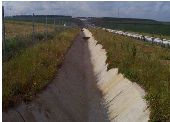
Fossé trapézoïdal revêtu en béton muni de cloisons afin de limiter la vitesse des écoulements.
