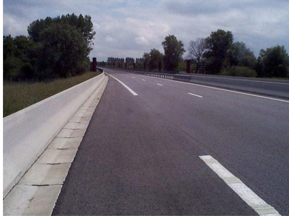
Caniveau rectangulaire recouvert par un couvercle béton placé devant la glissière
