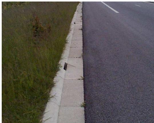
Ouverture dans le couvercle béton pour l'injection des eaux dans le caniveau rectangulaire
