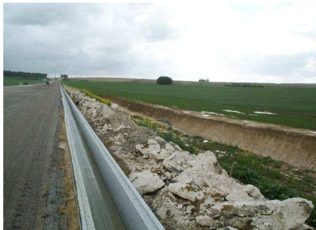
Caniveau rectangulaire coulé en place avant la réalisation de la chaussée.
