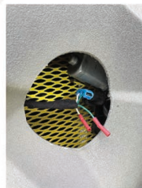
Grillage de sécurité
