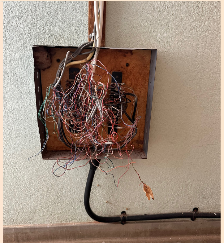
Typischer Anblick: Kabelchaos in der internen Telefonzentrale
