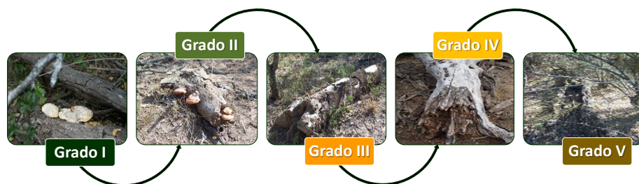
Figura 3. Grados de deterioro de MM evaluados.
