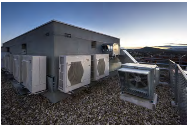
El sistema de climatització és d'aerotèrmia per a calefacció, ACS i refrigeració.
