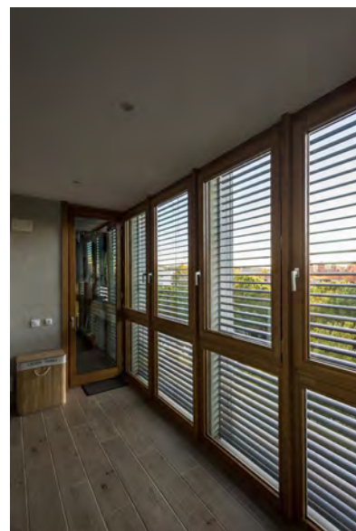
Finestres i balconeres de fusta amb persianes enrotllables motoritzades d'alumini.
