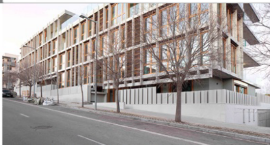
Exterior y escaleras interiores del bloque de viviendas. Foto: José Hevia
