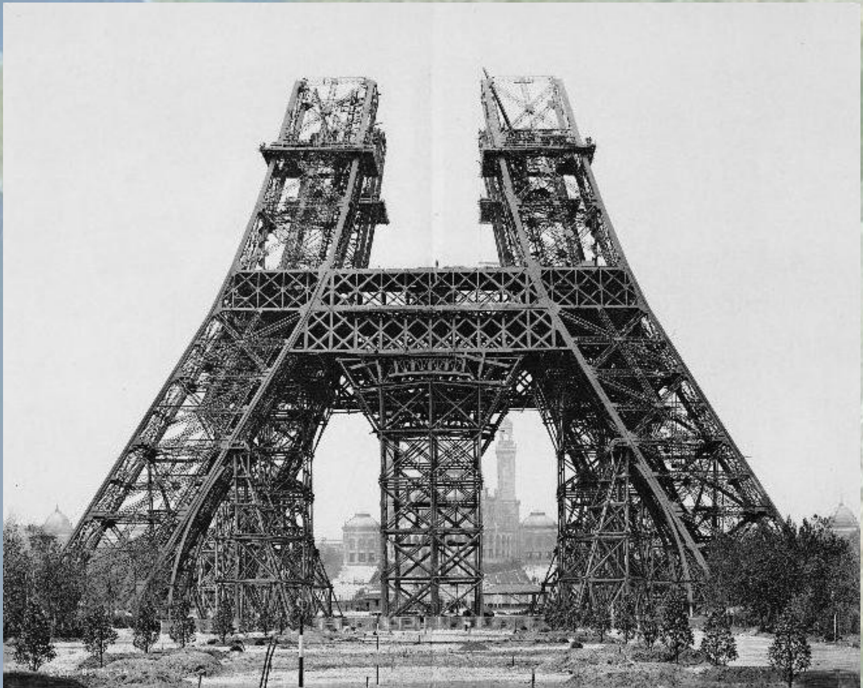
Construction de la Tour Eiffel 1887-1889
