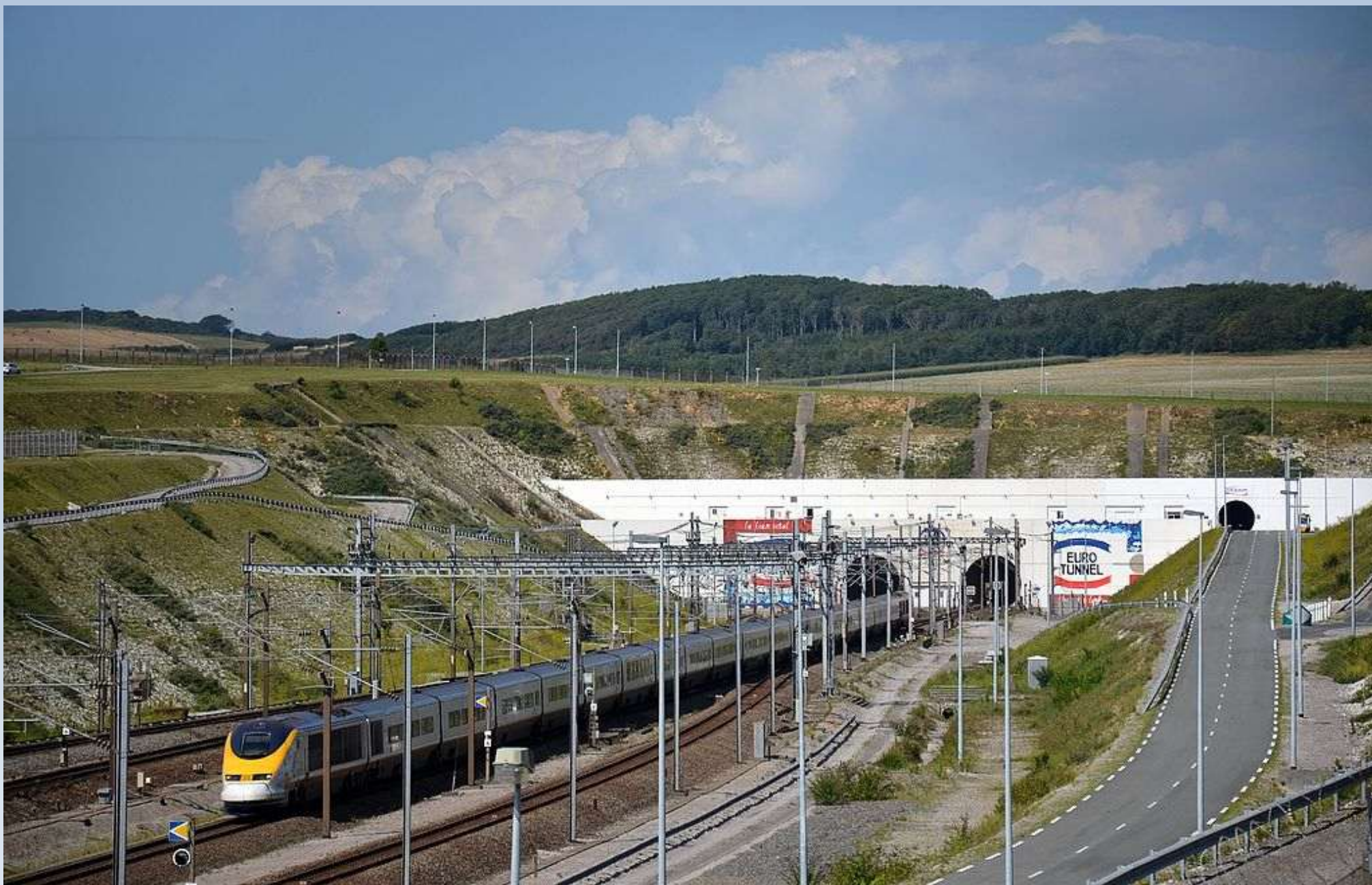
Un Eurostar à la sortie du tunnel sous la Manche.
