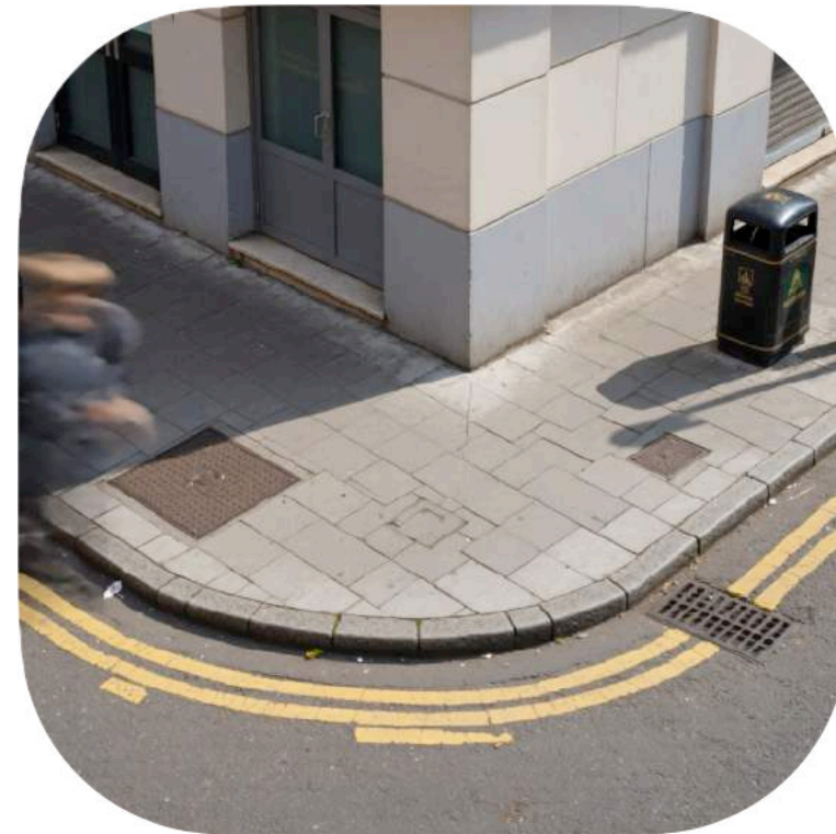
Contrasto al degrado urbano
