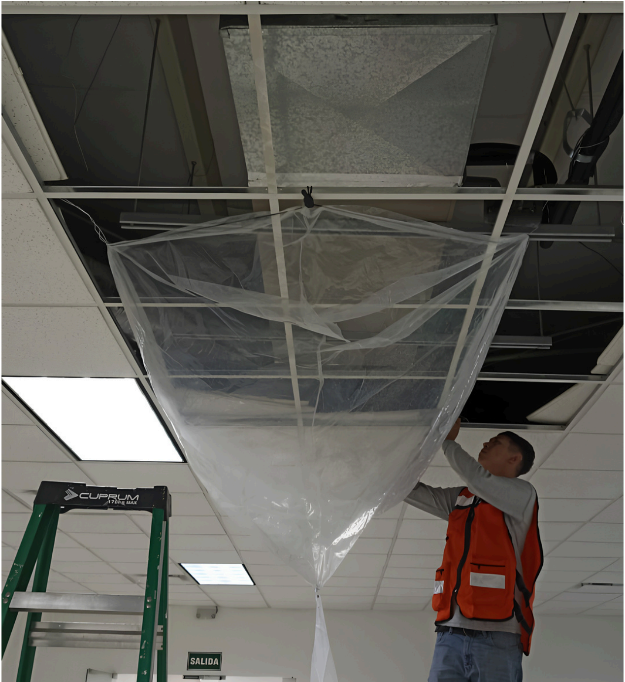
Mantenimiento preventivo a Unidad tipo Cassette
