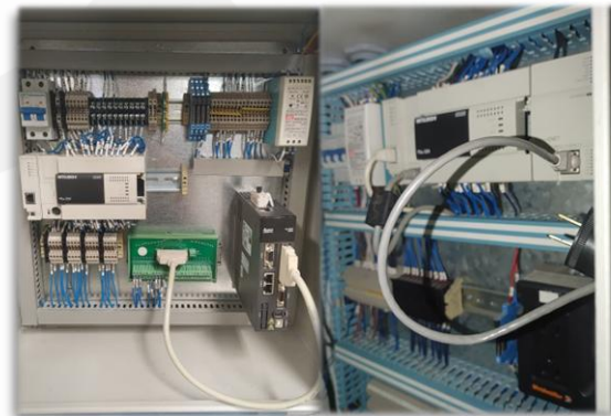
Distribución y cableado de tableros.
