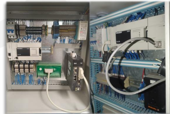
Distribución y cableado de tableros.
