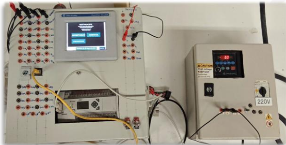
Fabricación de tableros.
