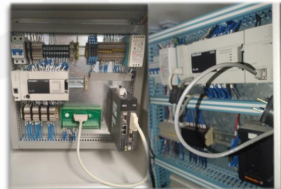
Distribución y cableado de tableros.
