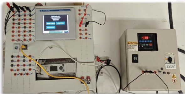
Fabricación de tableros.
