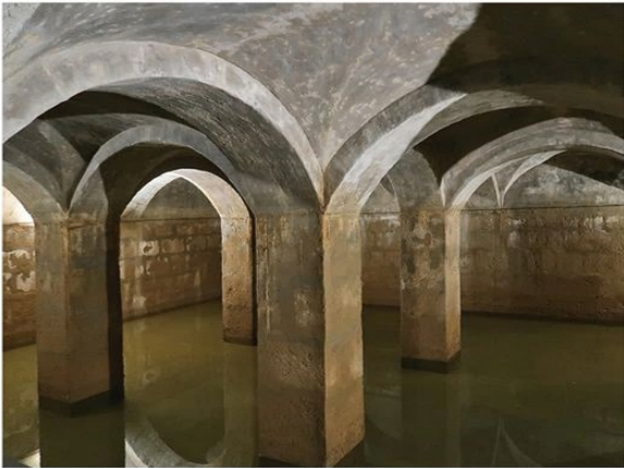
Aljibe de Villalón de Campos
