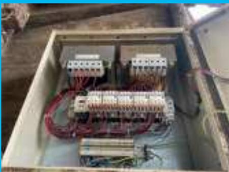
LE TABLEAU ÉLECTRIQUE QUI ALIMENTE L'ARMOIRE DES VENTILATEURS EN 380 VOLTS AVEC UN CÂBLE QUATRE CONDUCTEURS (TROIS PHASES + TERRE) SANS LE CONDUCTEUR NEUTRE.
