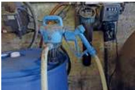
POSER UN COUPE-CIRCUIT SUR LA POMPE À FUEL OU PENSER À DISJONCTER LE COMPTEUR QUI COMMANDE LA POMPE EN FIN DE JOURNÉE SONT DES GESTES PRÉVENTIFS SIMPLES À METTRE EN ŒUVRE.
