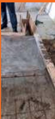
Pour couper le champ magnétique de 50 Hertz qui rayonnait depuis le câble souterrain de 380 volts non blindé, une dalle en béton ferraillée
