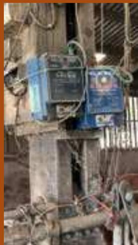
UN EXEMPLE À NE PAS SUIVRE : LES ÉLECTRIFICATEURS SONT PERCHÉS À L'INTÉRIEUR DE LA STABULATION. LEUR PRISE DE TERRE EST RACCORDÉE AUX CORNADIS. LES VACHES SE PRENNENT EN PERMANENCE DES DÉCHARGES ÉLECTRIQUES.
