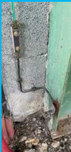
**UN EXEMPLE DE MAUVAISE PRISE DE TERRE : LE CÂBLAGE DE LIAISON TERRE PASSE PAR LA CHARPENTE MÉTALLIQUE.**
