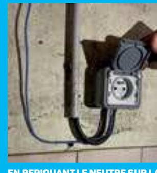
EN REPIQUANT LE NEUTRE SUR LA PRISE DE COURANT DE 220 VOLTS POUR ALIMENTER LA SONDÉ DES VENTILATEURS, L'INSTALLATEUR A CRÉÉ UN CHAMP ÉLECTRIQUE ET ÉLECTROMAGNÉTIQUE CONSIDÉRABLE.
