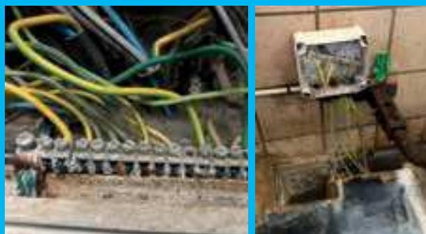
**DES EXEMPLES DE TRACES D'HUMIDITÉ SUR LES INSTALLATIONS ÉLECTRIQUES SIGNALANT UN PROBLÈME.**
