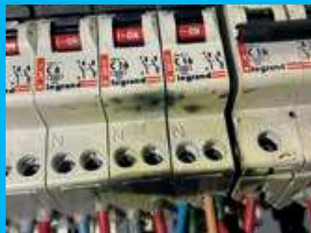
LE CONTACTEUR UNIPOLAIRE QUI ALIMENTE LE RÉSEAU 220 VOLTS DE LA PRISE DE COURANT, QUI, VIA UN RETOUR DU COURANT SUR LE NEUTRE, A OCCASIONNÉ DES SURCHARGES ÉLECTRIQUES.
