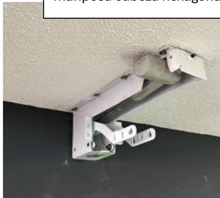
Conecte los cables del motor al sistema electrónico y conetcte el sistema a la corriente. Pruebe el motor subiendo y bajando para verificar su correcto funcionamiento con el control remoto.
