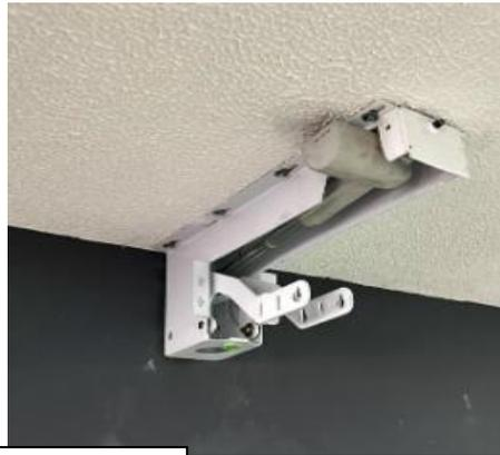
Asegure el motor en los 7 puntos, Usar chazo mariposa cabeza hexagonal 10mm
