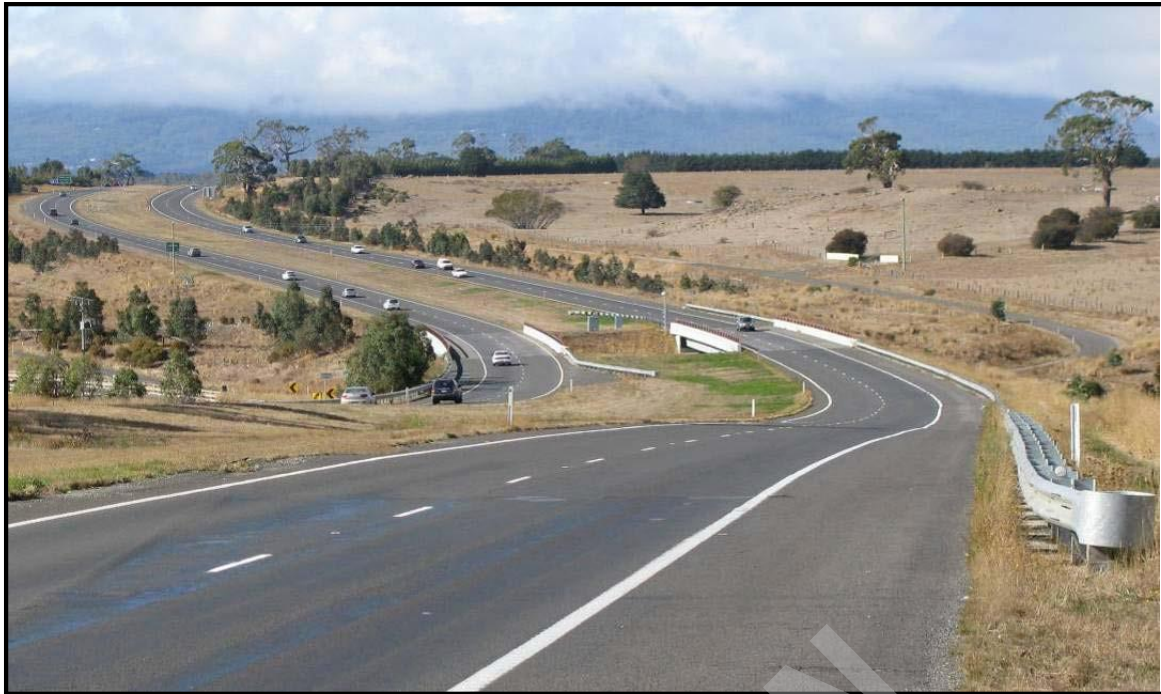
Gambar 5-84. Jalan yang sangat pas dengan kondisi medan
