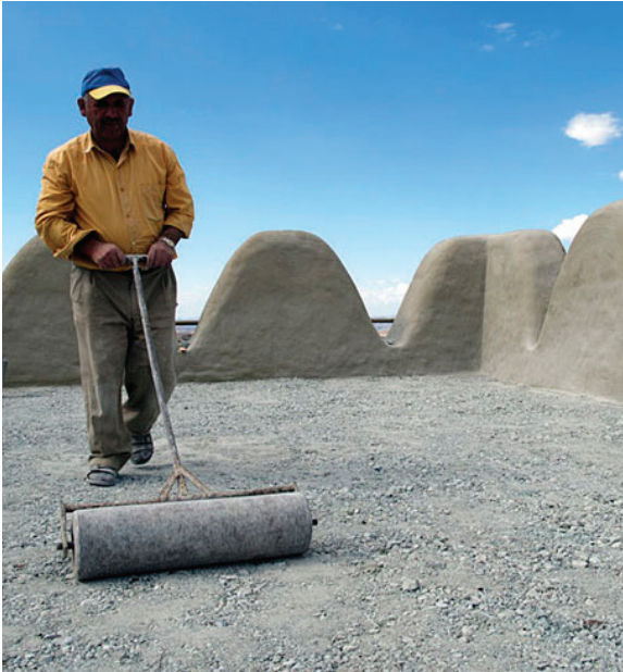
Görüntü-22 Toprak dam sıkıştırma, Hattuşaş rekonstrüksiyonu
