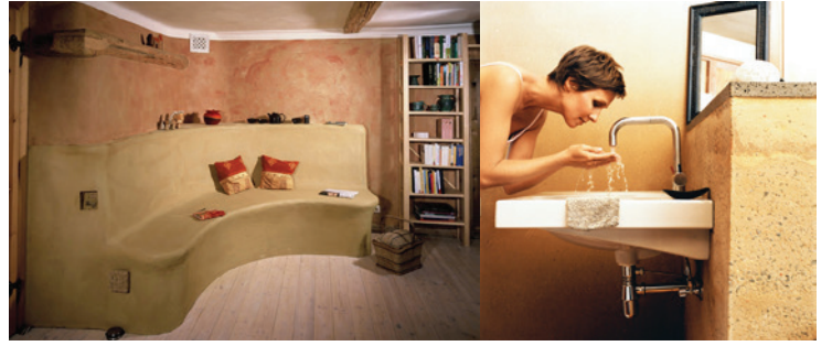
Görüntü-12-13 Toprak sedir (solda) ile lavabonun monte edildiği toprak donatı
