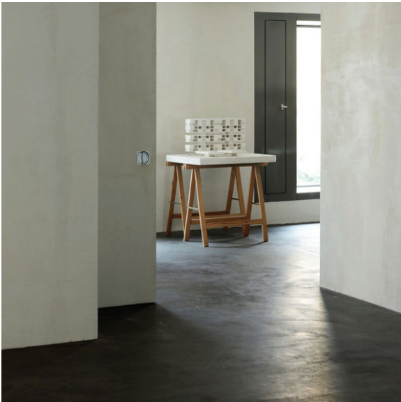
Görüntü-08 Sıkıştırıldıktan sonra bitkisel reçine yedirilmiş döşeme
