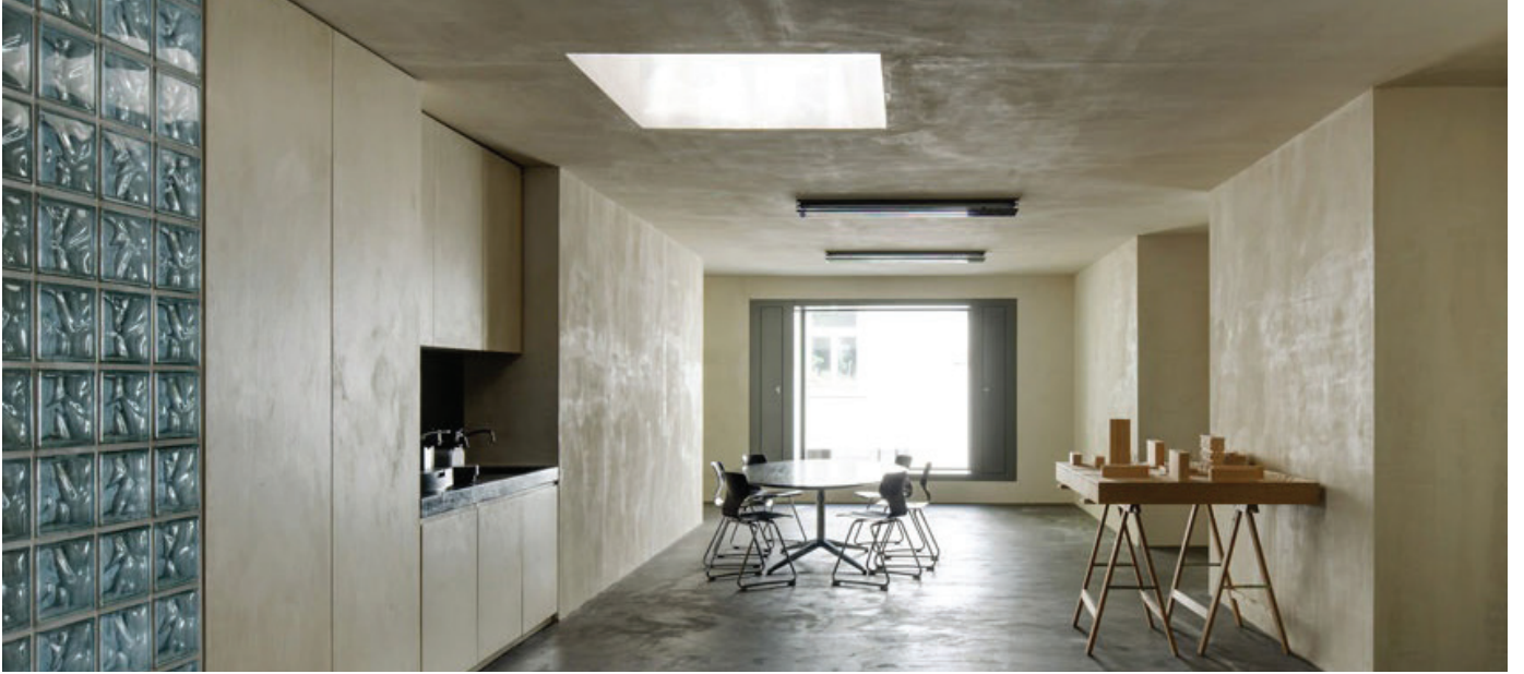
Görüntü-21 Toprak panellerden oluşan duvar ve tavanlar ile sıkıştırma toprak döşeme
