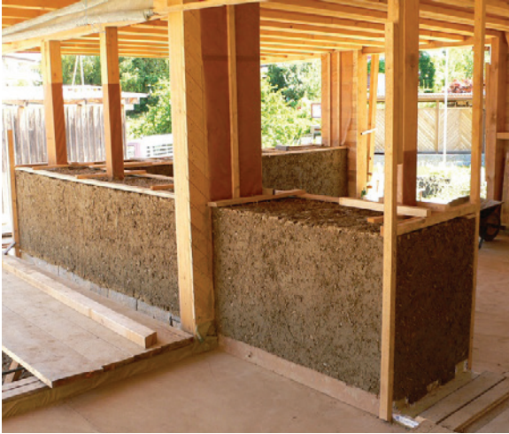
Görüntü-07 Kuru ot katkıli ahşap konstrüksiyon arası toprak duvar
