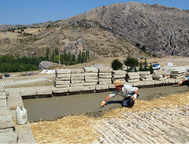
Görüntü-09 Toprak Dam inşaatı, Hattuştaş reskonstrüksiyonu
