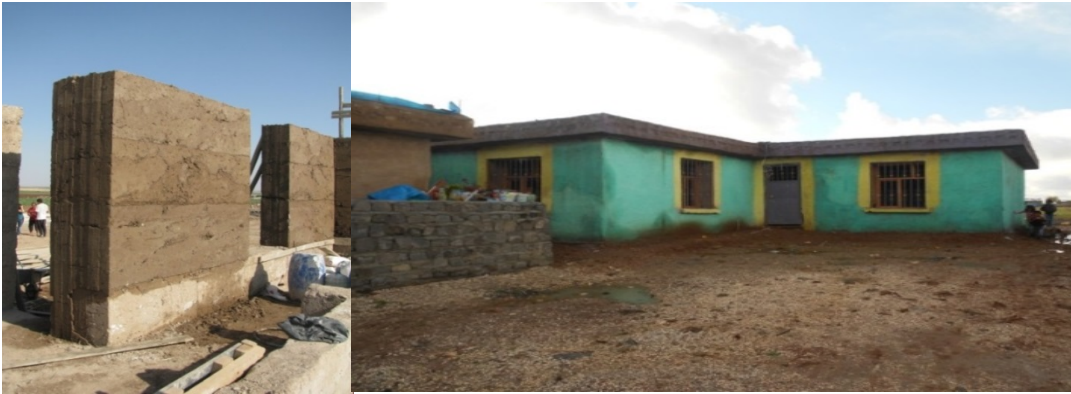
Şekil 20- Şanlı Urfa/ Viranşehir'de Toprak-Su Kollektifi' nde ALKER karışımıyla yapılan evlerden birine ait duvar ve yapının bitmiş hali (Foto: Solhan E.)
