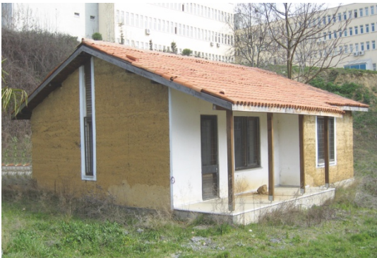
Şekil 18- II. Deneme Evi'nin sıvasız duvarlarının yapımından 20 sene sonra hiçbir yıpranma saptanmayan 2015'teki görünümü (Foto: Kafescioğlu M.)
