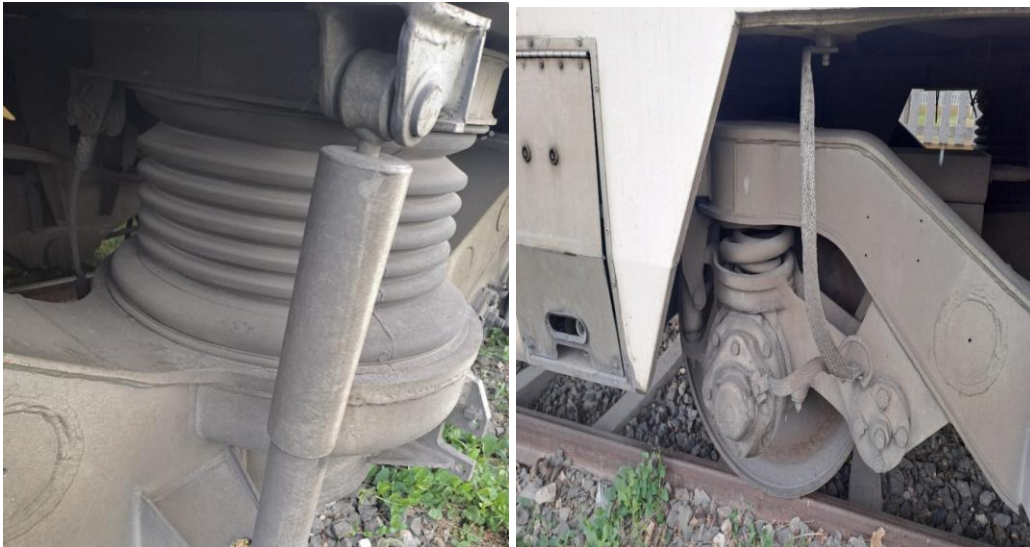
Şekil 14. Y32 bojideki helezon sustaların sökülmesi ve montajı
