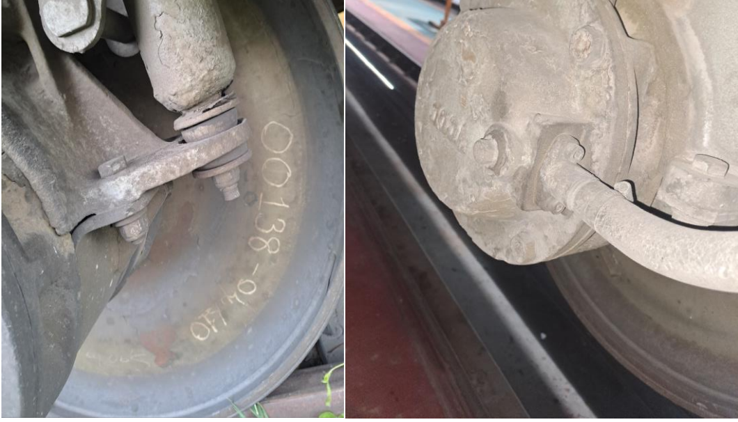
Şekil 6. TVS tipi vagonlarda bojiler sökülmeden tekerlek takımlarının birleştirilmesi
