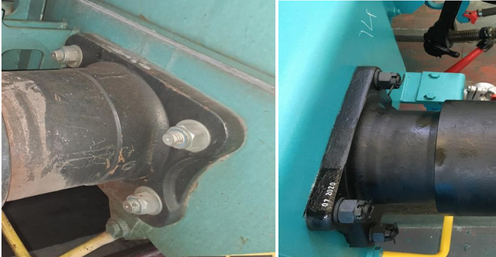
Şekil 8. Tamponların sökülmesi ve montajı
