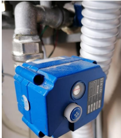
Şekil 83. Oda lavabo altında bulunan otomatik boşaltım sistemi
