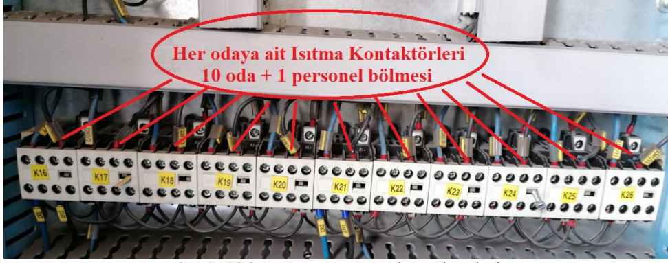
Şekil 134. Cam önü ısıtma kontaktörleri
