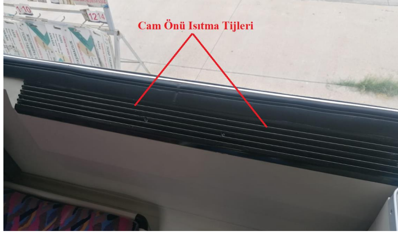
Şekil 137. Cam önü ısıtma tijlerinin bulunduğu yer
