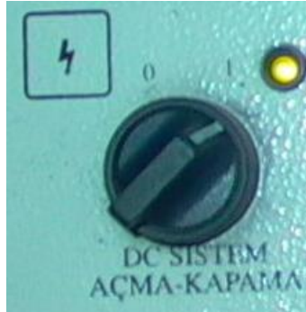
Şekil 35. DC sistem açma kapama
