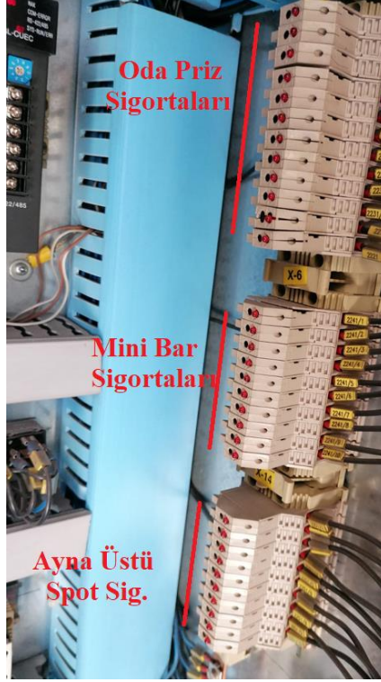
Şekil 136. E-1 Dolabı içinde bulunan 220 cam tüp sigortalar
