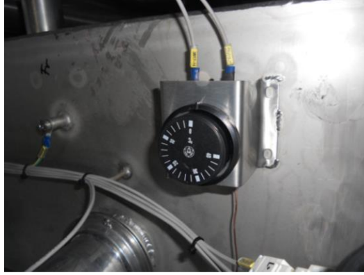
Şekil 129. Atık tankı hazne içi termostad
