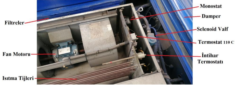
Şekil 76. Evapororotor ünitesi
