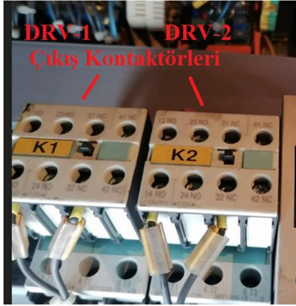
Şekil 12. DRV-1 ve DRV-2 çıkış kontaktörleri
