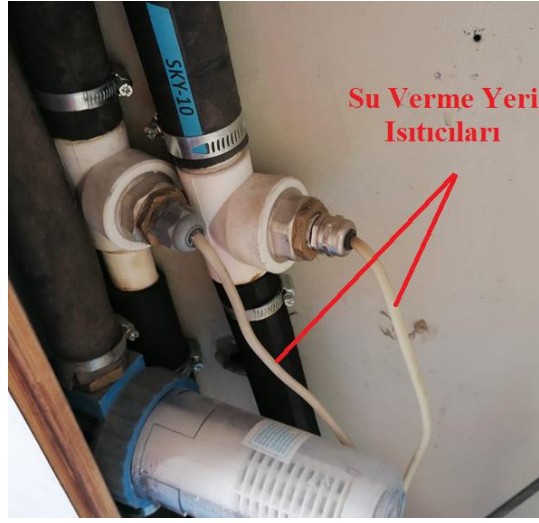
Şekil 79. Su basma yerleri ısıtıcı kabloları
