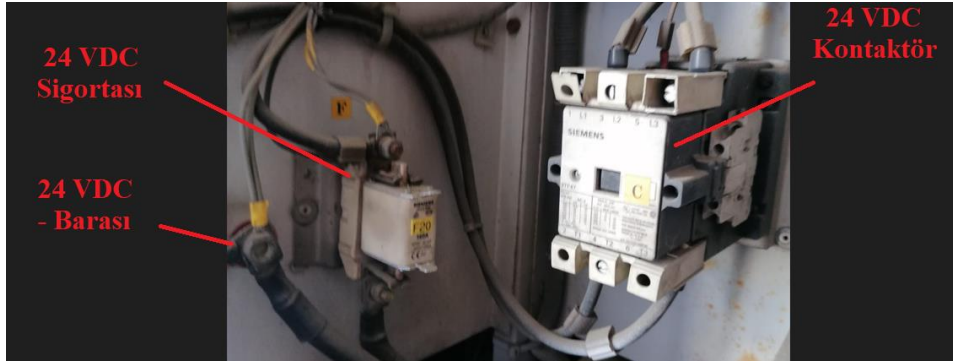
Şekil 43. E-2 pano içi 24 VDC kontaktörü
