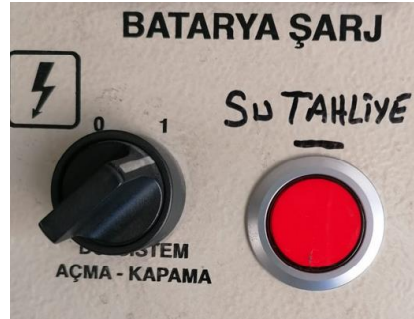
Şekil 82. Tek noktadan otomatik su boşaltım butonu
