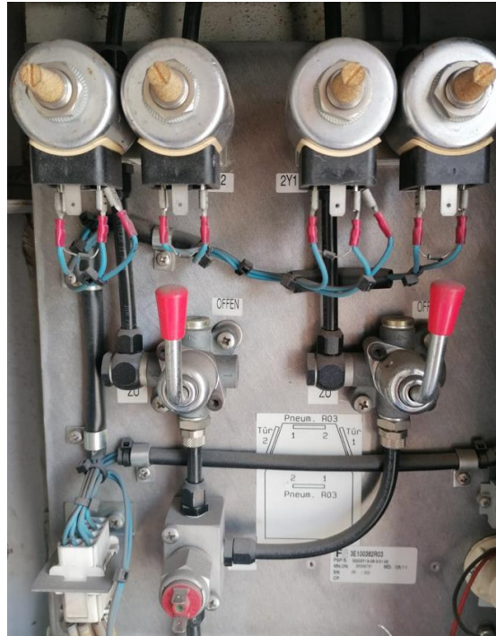
Şekil 86. Kapı açma ve kapama valfleri
