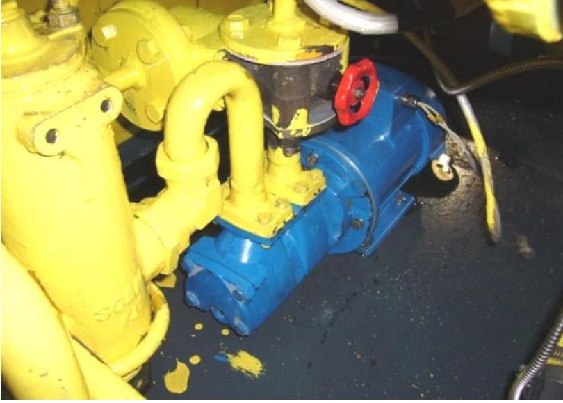
Şekil 94: Yakıt ikmal motoru ve pompası
