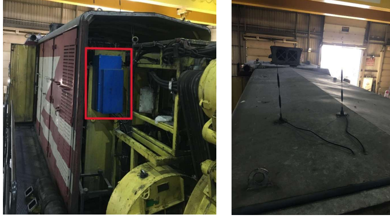
Şekil 196. DE 24000 tipi lokomotif veri izleme sistem panosu ve GPS ile GSM antenleri
