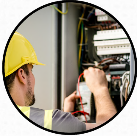
ESTUDIOS Y PERITAJE ELÉCTRICO
