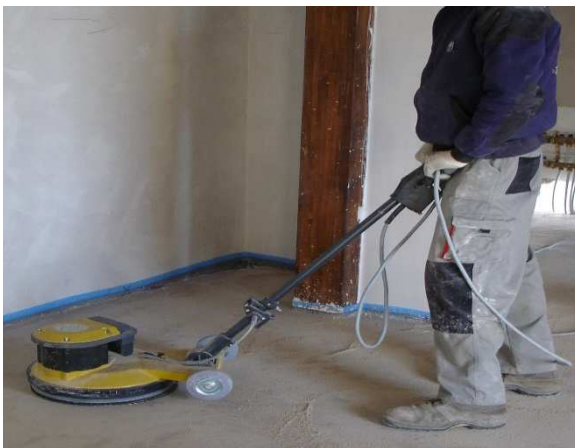
Paso 3: Lijado, previo secado de la solera
