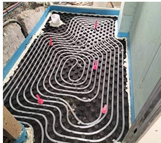
Sellado de la instalación con espuma de poliuretano
