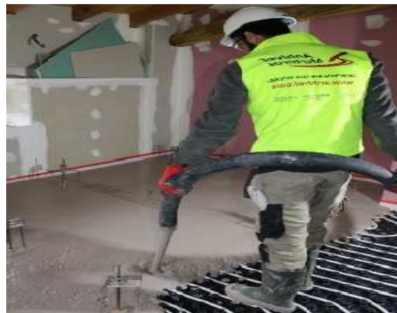
Paso 2: Aplicación del mortero
