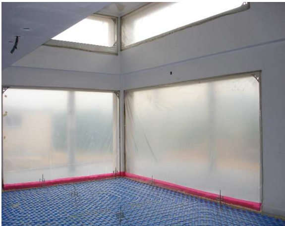
Paso 1: Tapado de huecos fachada y sellado
