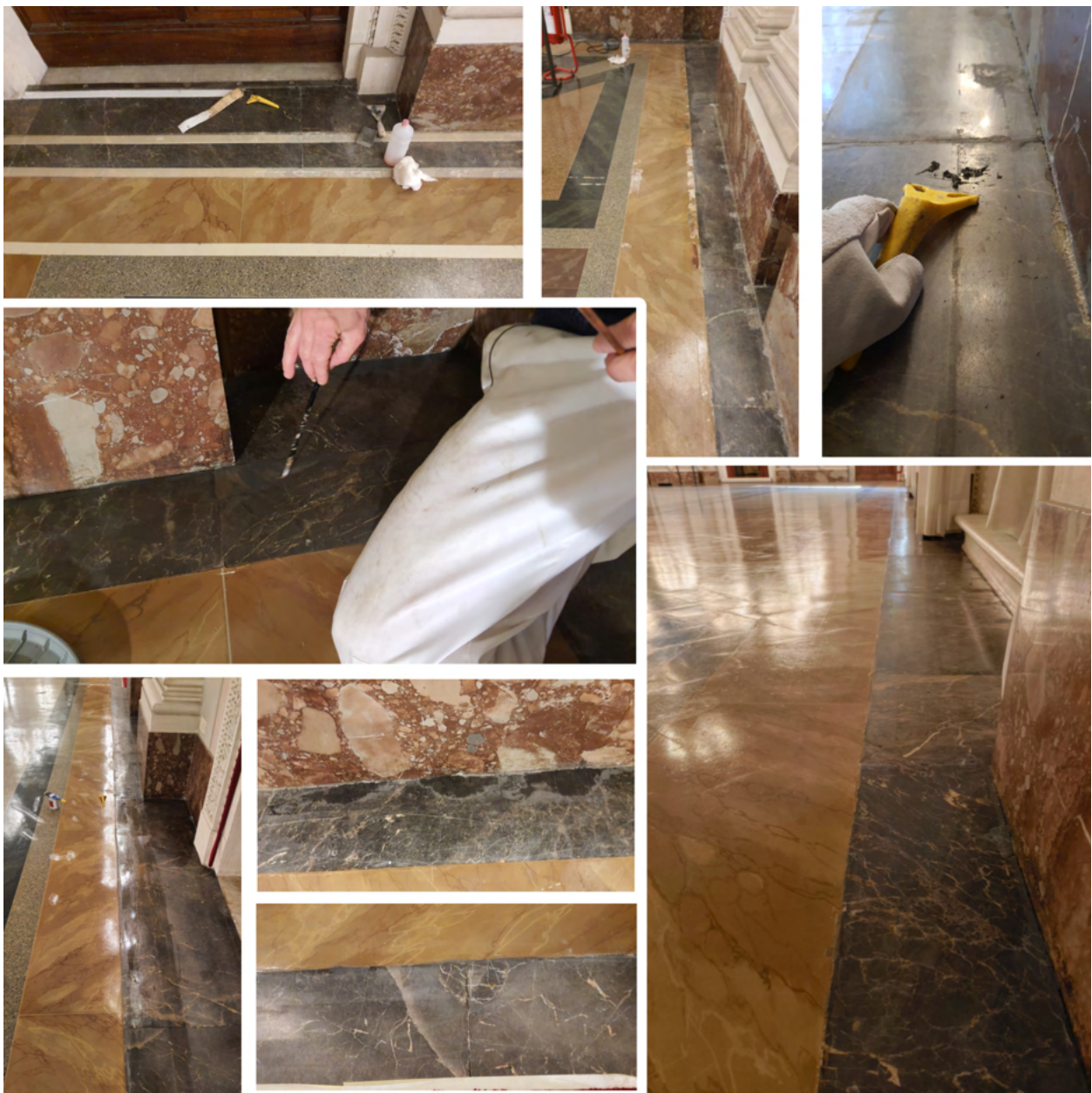
restauro della fascia perimetrale in marmo
