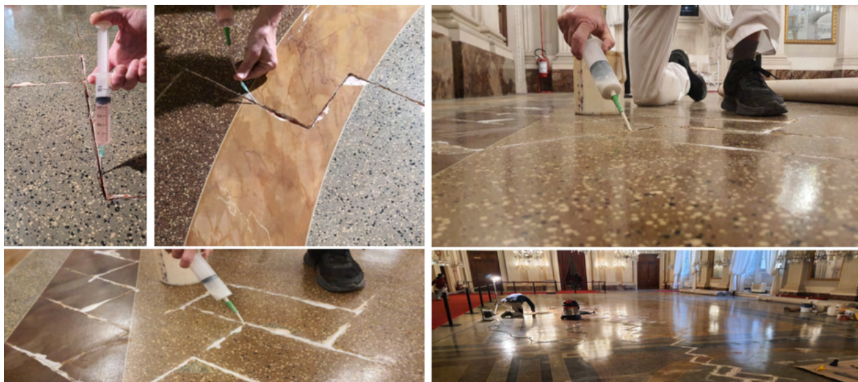
operazione di consolidamento
