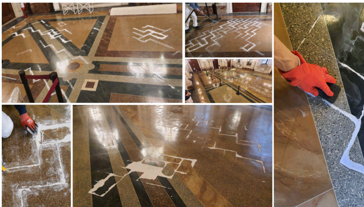
operazioni di stuccatura
