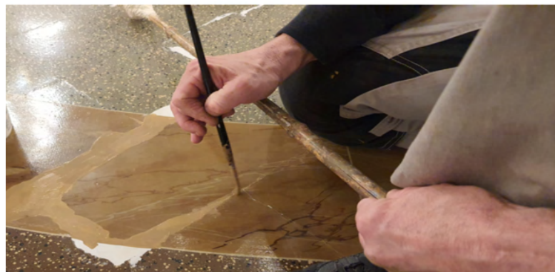
integrazione pittorica delle lacune
