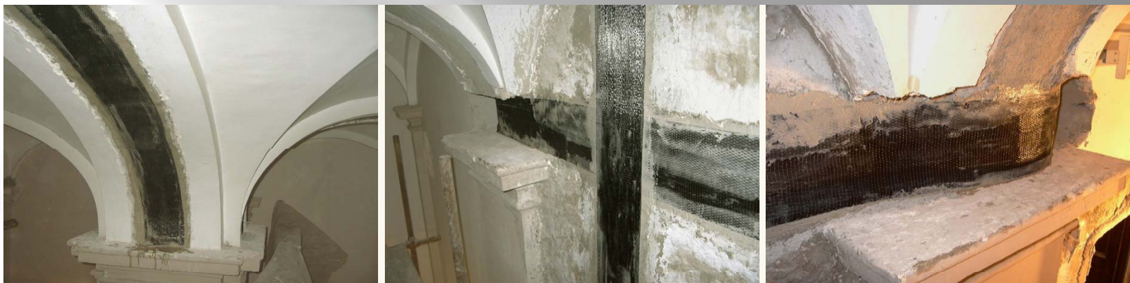
1 2 3. CONSOLIDAMENTO STRUTTURALE MEDIANTE FASCE IN FIBRA DI CARBONIO, PARTICOLARI DELLO SCALONE
