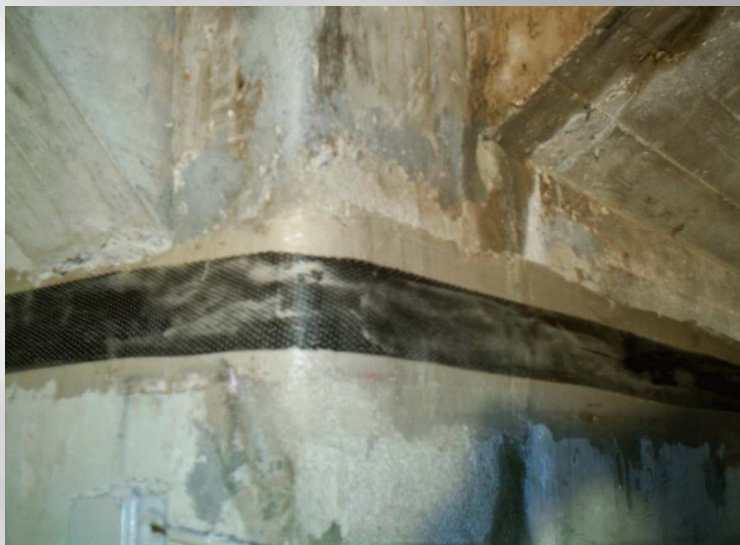
CONSOLIDAMENTO DELLA VASCA CON FASCE IN FIBRA DI CARBONIO
