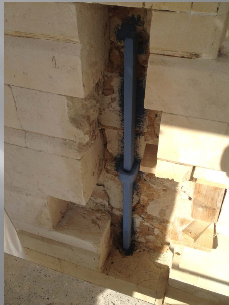
PARTICOLARE DELL'INTERVENTO DI COSOLIDAMENTO STRUTTURALE
