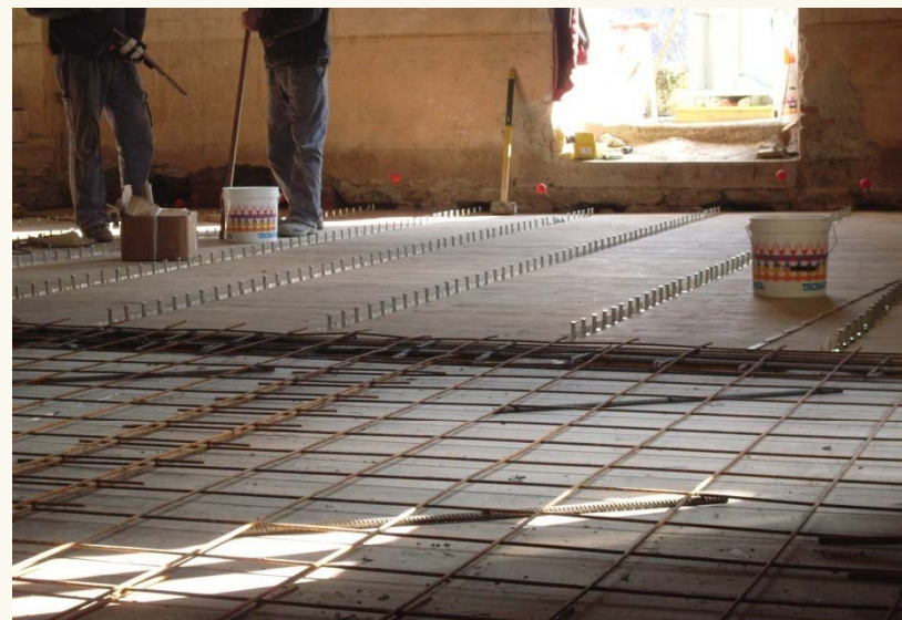
FASE DI ESECUZIONE DEL SOLAIO IN LEGNO
