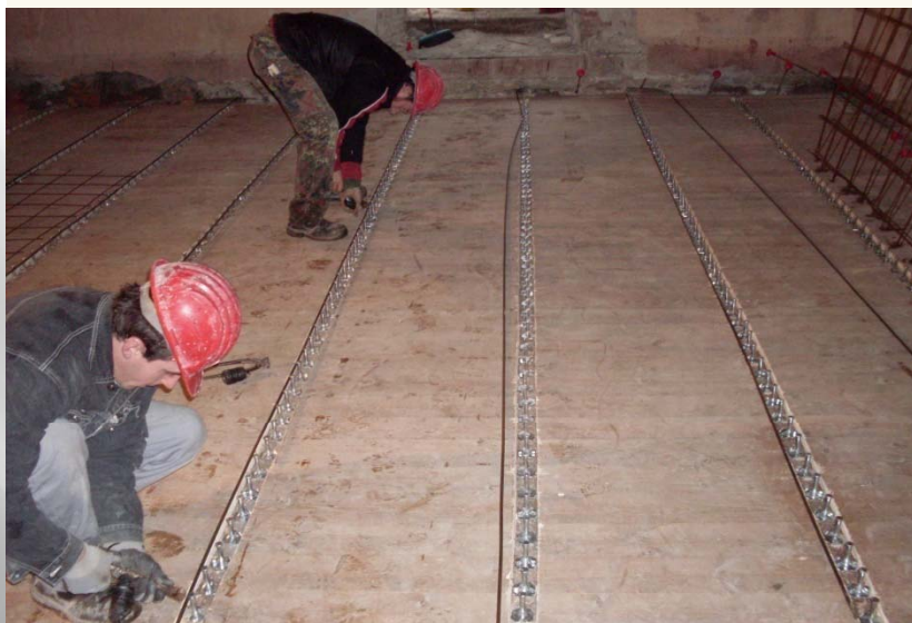
FASE DI ESECUZIONE DEL SOLAIO IN LEGNO
