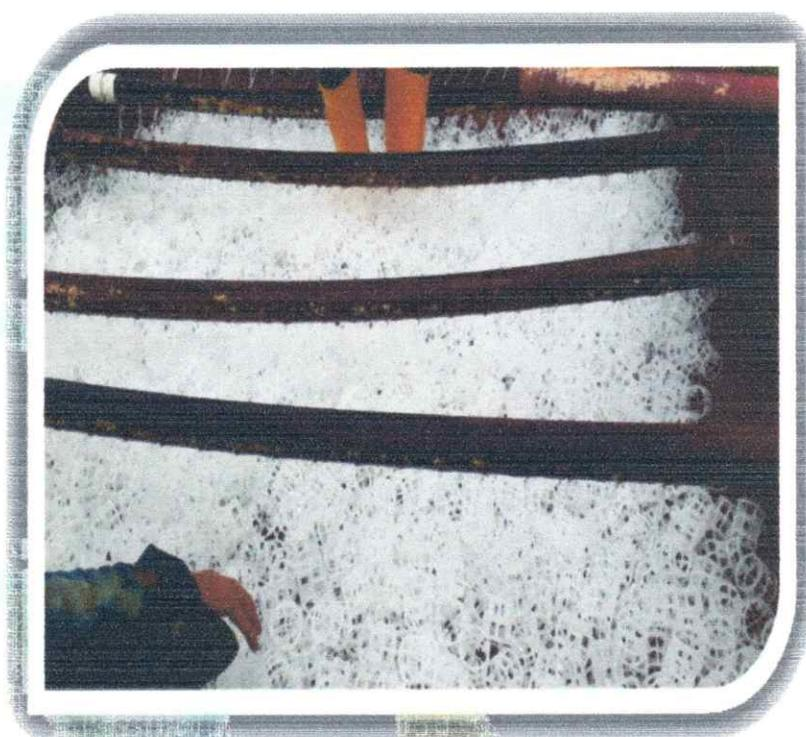
Esta actividad se debe realizar cada seis (6) meses, lavado interno y externo de la estructura para evitar colmatación de sedimento y evitar que este sedimento pase a los siguientes procesos.
