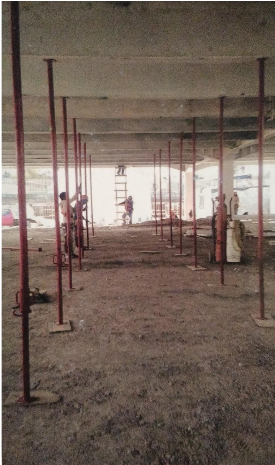
Re apuntalamiento de losa con puntales
