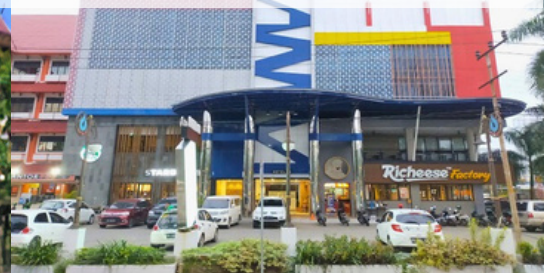
Gedung Posindo Plaza (Hotel 88 + Resto), Banjarmasin
