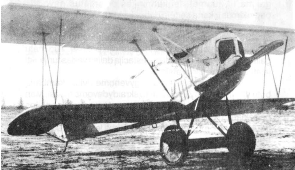
Fokker D VII - geriausias I-mojo pasaulinio karo vokiškas naikintuvas. Lietuvos karo aviacijoje tarnavo iki 1940 m. Turėjo 160 AG variklį, pasiekdavo maksimalų 190 km/h greitį. Kelis tokio tipo lėktuvus pastatė Kauno aviacijos dirbtuvės.
