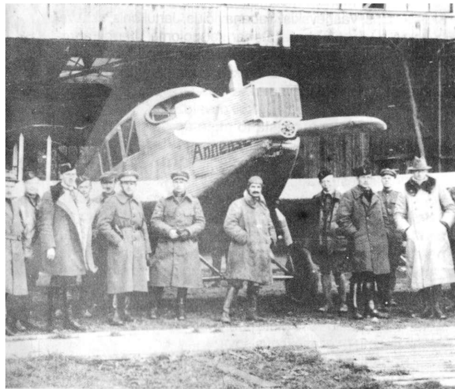
Kauno aerodrome - internuotas vokiečių lėktuvo Junkers F 13 prototipas ("Annelise"). Tai pirmas pasaulyje ištisai metalinės konstrukcijos, dengtas duraliuminio skarda lėktuvas. 1919 spalio.
