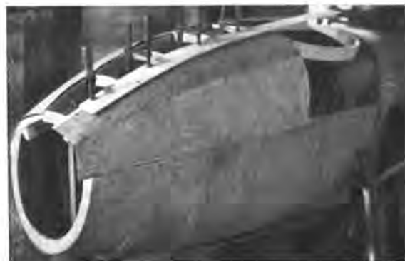
Abb. 130. Sperrholz wurde teilweise aufgezogen.
