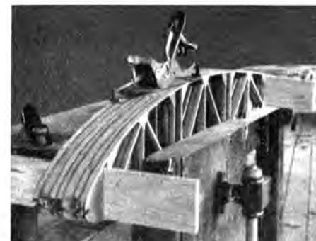
Abb. 52. Beiputzen von Rippen.
