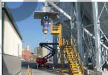
ESTRAZIONE A MEZZO COCLEE TRASPORTATRICI EXTRACTION BY SCREW CONVEYORS
