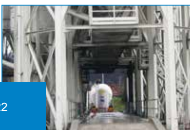
STRUTTURA A PORTALE PER PASSAGGIO CAMION GANTRY STRUCTURE FOR VEHICLES TRANSITING
