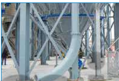
DETTAGLIO TUBAZIONE DI CARICO DETAIL OF PNEUMATIC FILL PIPE
