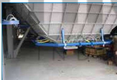
DETTAGLIO FLUIDIFICAZIONE A CANALINE
