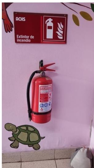
HALL PRIMER PISO
