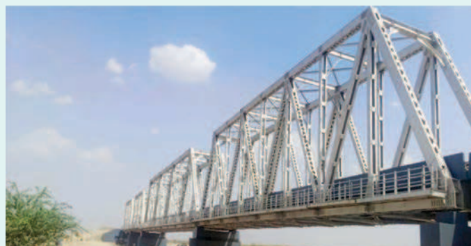
डेडीकेटेड टेस्ट ट्रैक पर मानक मापदंडों के अनुरूप निर्माण कार्य
