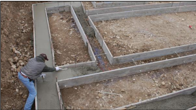
Pouring foundation footers
