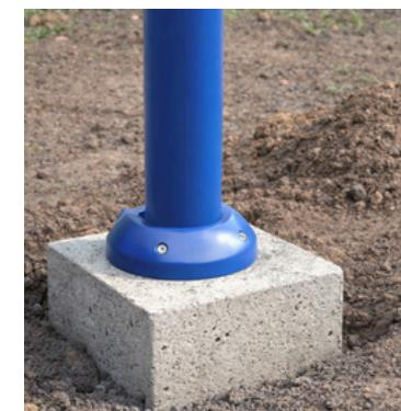
Mettre le capot de protection en bas de la poutre centrale et serrer les écrous à l'aide d'une clef type BTR.
