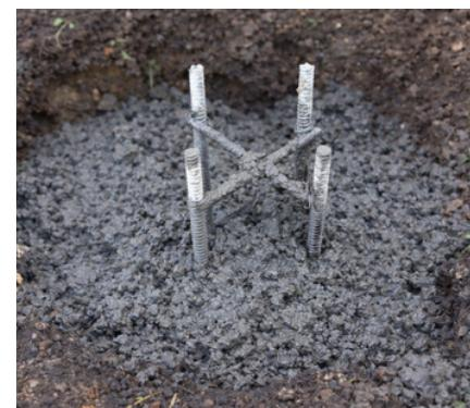
Placer le support dans la fondation et veiller à laisser dépasser les parties filetées (tiges filetées de diam 20mm) de 50mm maxi.
