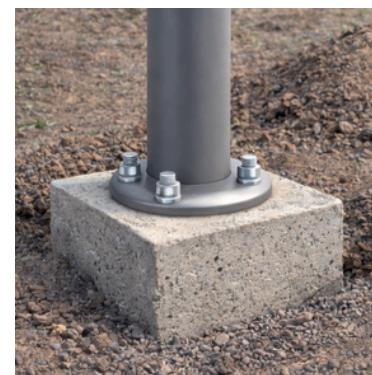
Positionner l'appareil sur le support et fixer les écrous. Vérifier le niveau vertical de la poutre centrale.
