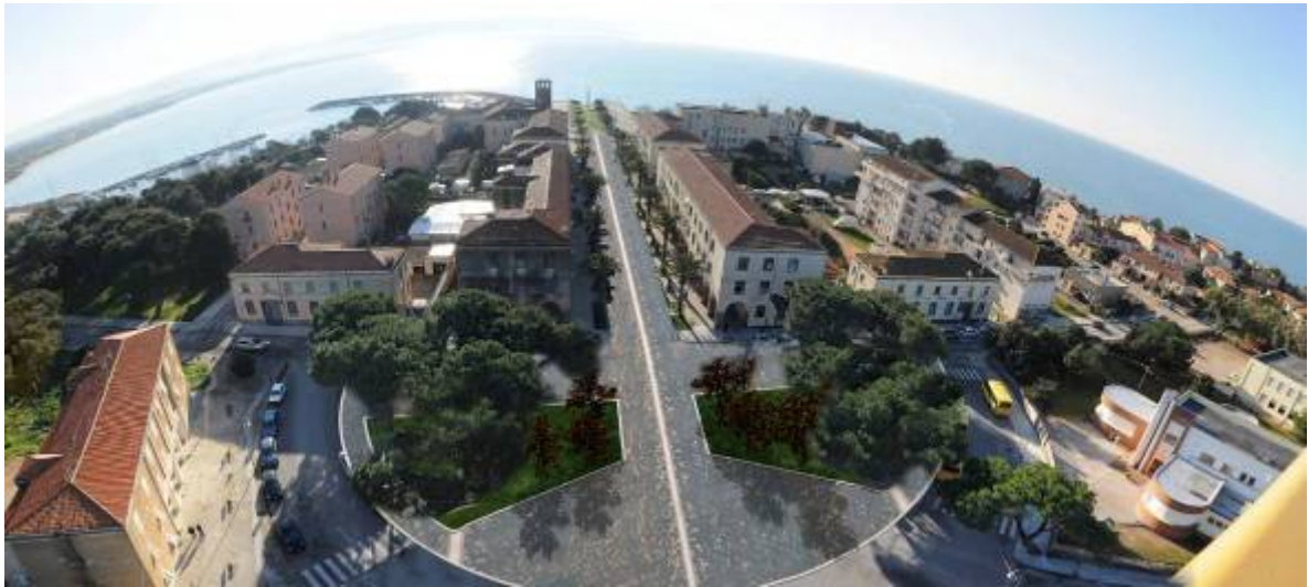
Fig. 15 – Ambientazione fotografica grandangolare della pavimentazione di Piazza Venezia Giulia e via Pola, chiuse ad traffico e pedonalizzate.
