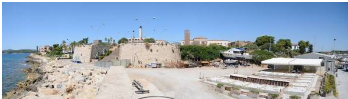
Fig. 65 – Stato attuale del waterfront di Fertilia: la presenza di imbarcazioni e materiali stoccati al di sotto del lato est di Piazzale San Marco, crea un forte degrado visivo.
