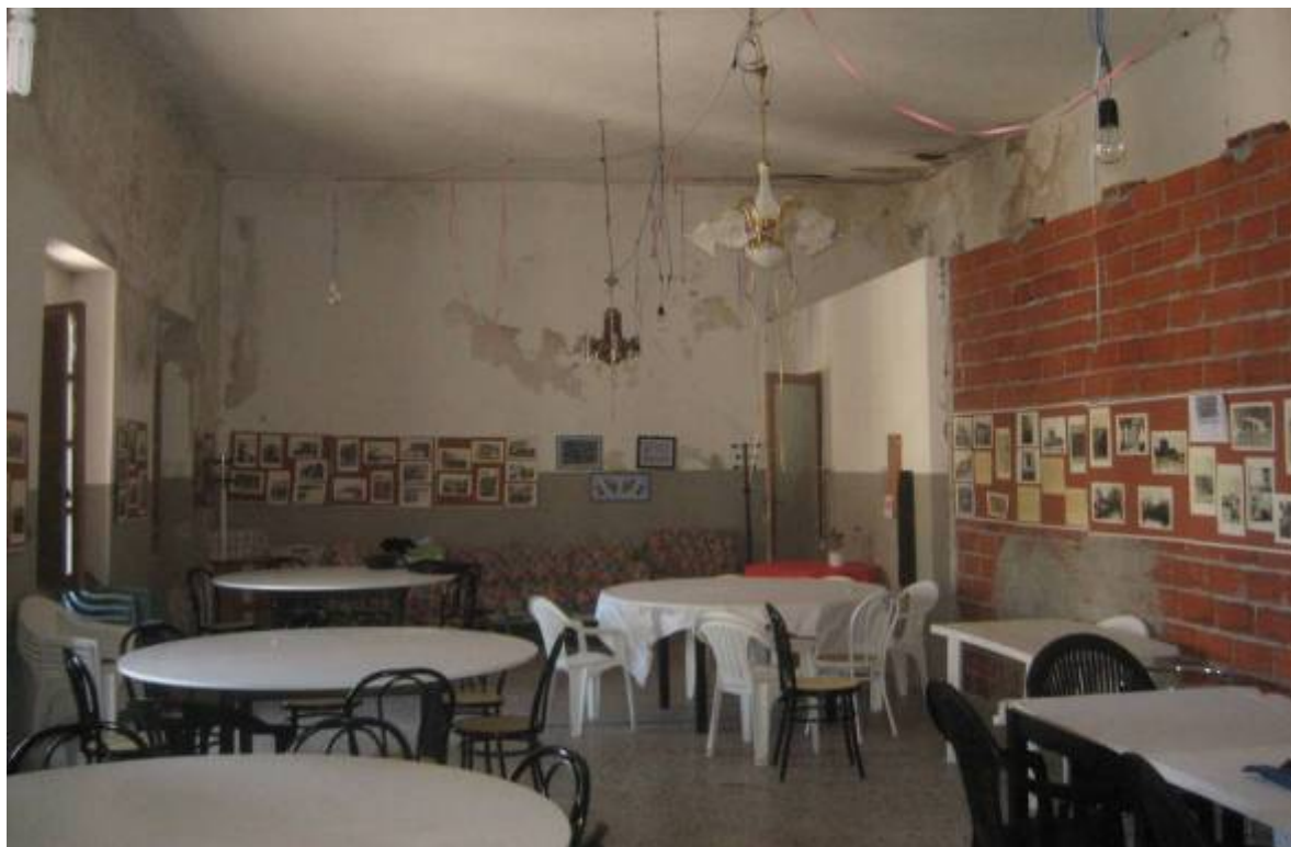
Fig. 35 – Ex Casa del Fascio - piano primo: la sede dell'A.N.V.G.D. Sulla destra la tramezzatura mediante la quale è stato ricavato un appartamento.
