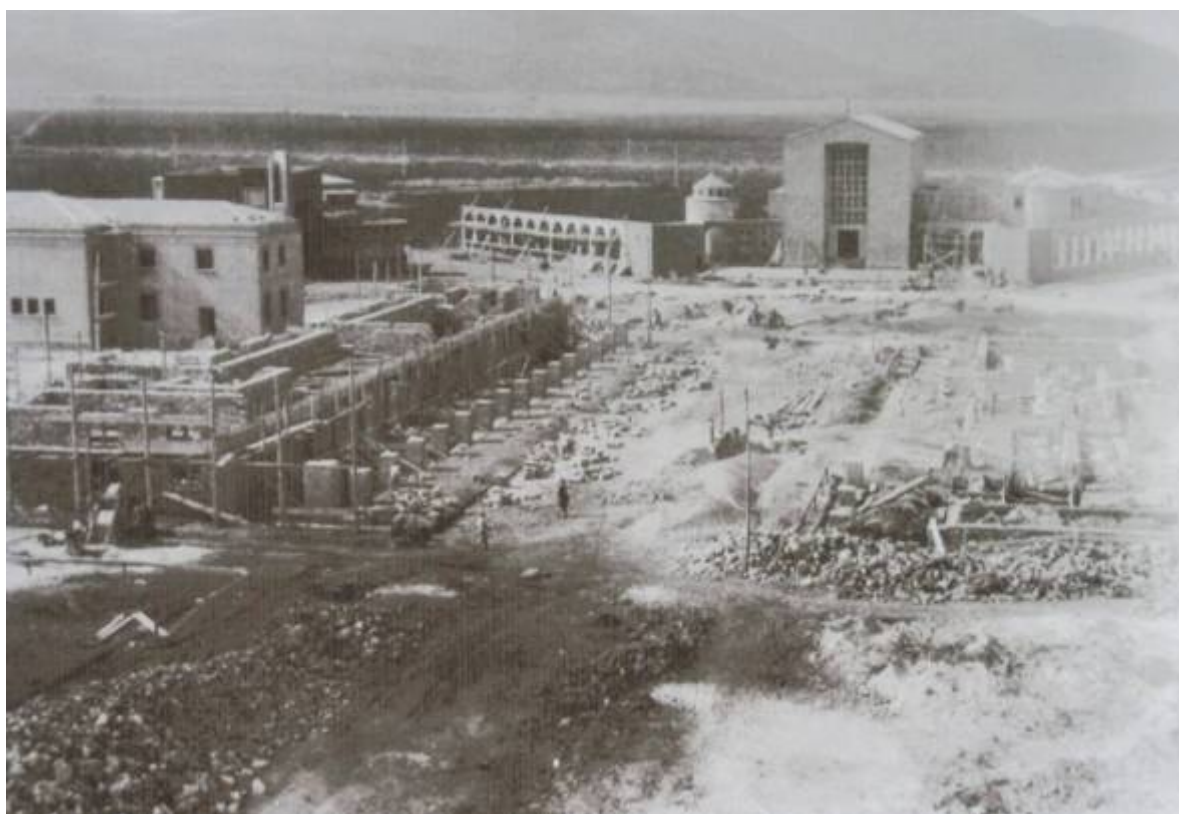
Fig. 9– I Portici (case Incis) della via Pola in costruzione negli anni '40.
