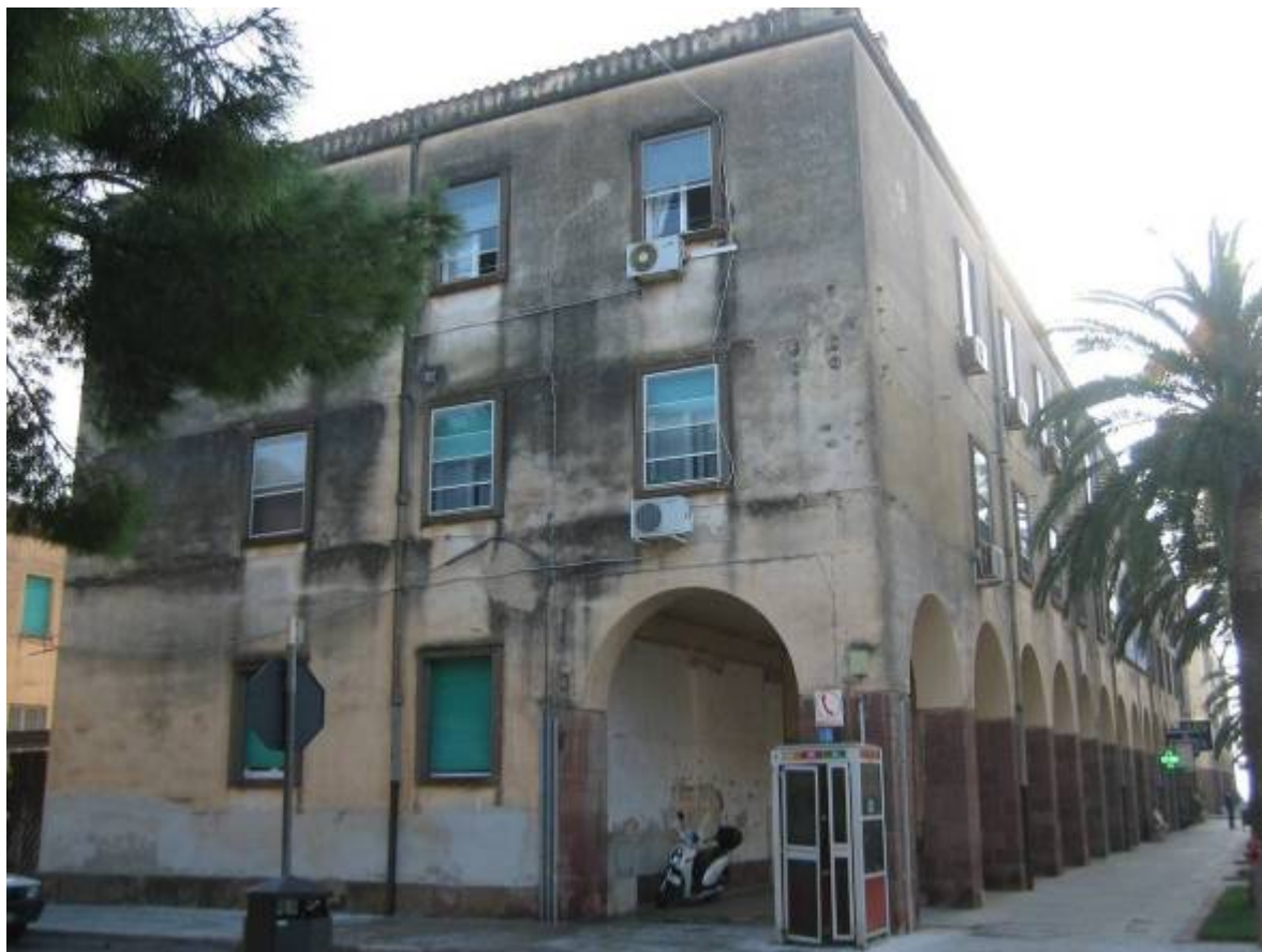
Fig. 70 – Prospetto principale sulla via Pola dell'edificio nord-est.
