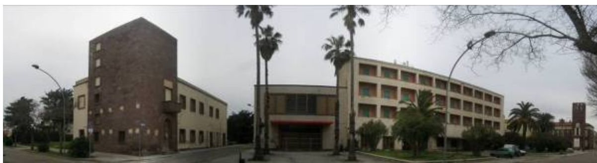
Fig. 21 – Fotomosaico panoramico grandangolare su Lungomare Rovigno. Da sinistra: Torre della Milizia ed ex Casa del Fascio; ex Cinema-Teatro; Albergo; Case I.N.C.I.S.; Torre e Palazzo Comunale; ex Ufficio Postelegrafico; ex Sede dell'Ente Ferrarese di Colonizzazione – E.F.C. (Palazzo Doria).
