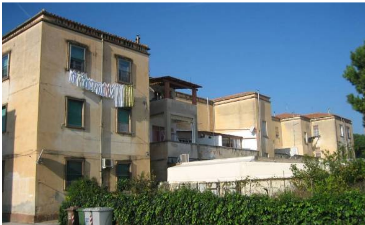
Fig. 71 – Prospetto tergale dell'edificio nord-est, con evidenti elementi rimaneggiati.
