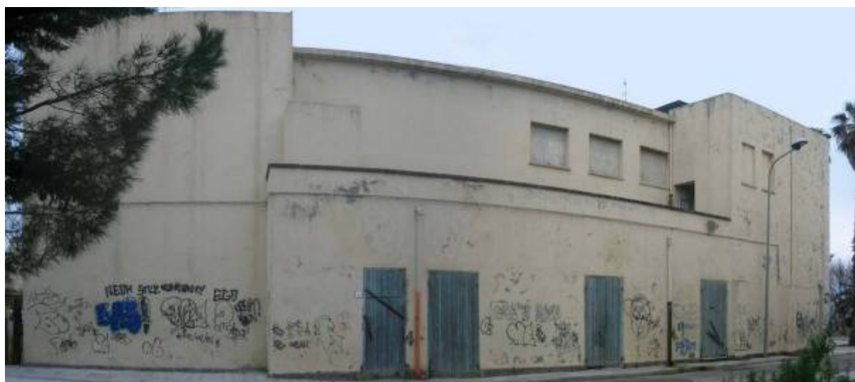
Fig. 25 – Ex Cinema-Teatro: panoramica grandangolare del prospetto su via Trieste. L'edificio, restaurato da quasi un ventennio, risulta in totale stato di abbandono oltre che oggetto di periodici atti vandalici.
