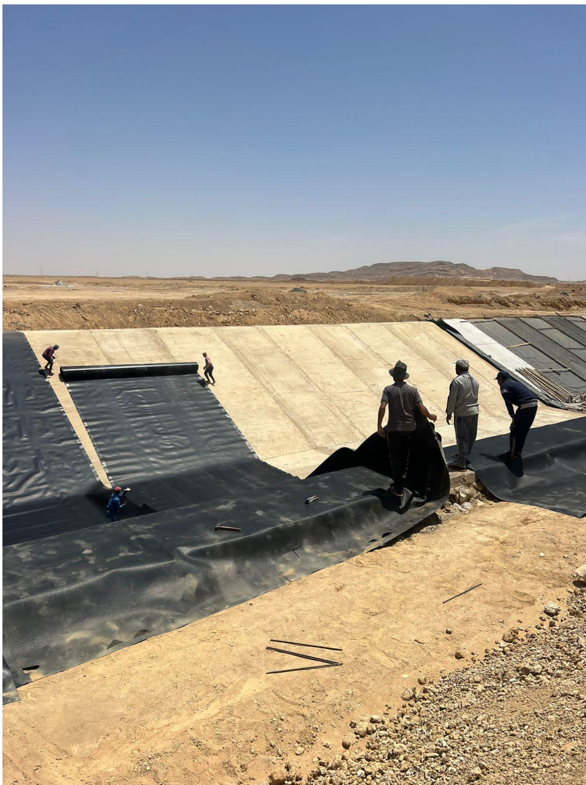
أعمال انشاء الترعر الناقله للمياه العكره - محافظه بنى سويف
