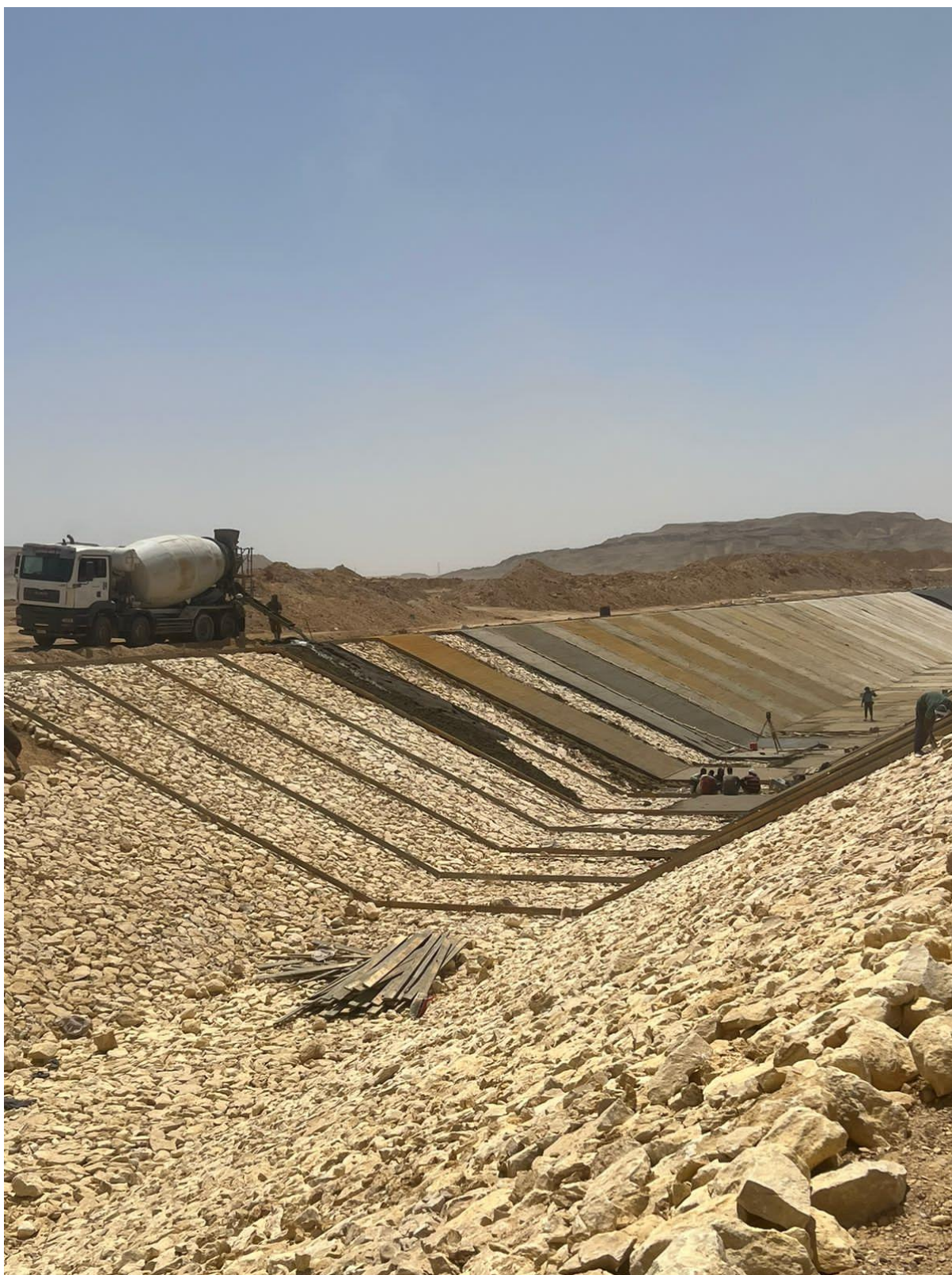
أعمال إنشاء الترع الناقلة للمياه العكرة - محافظة بنى سويف
