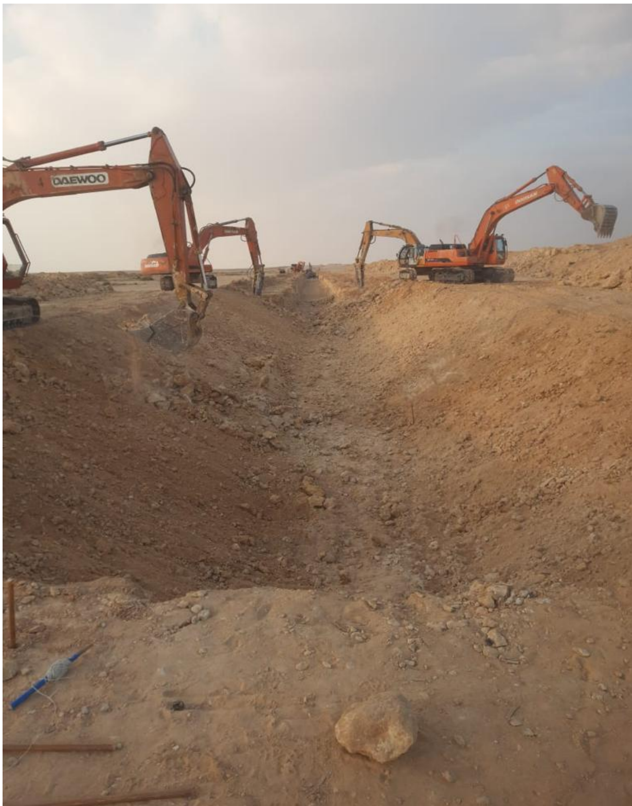
أعمال إنشاء الترعة الناقلة للمياه العكرة - محافظة بنى سويف
