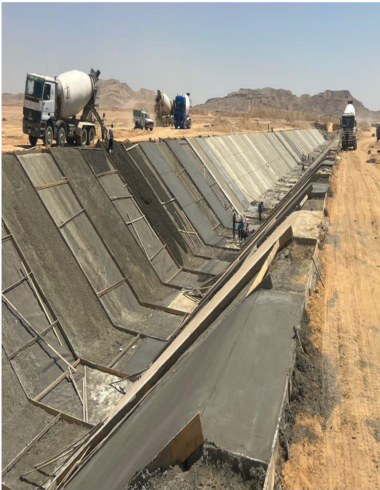
أعمال انشاء الترعر الناقله للمياه العكرة - محافظة بنى سويف
