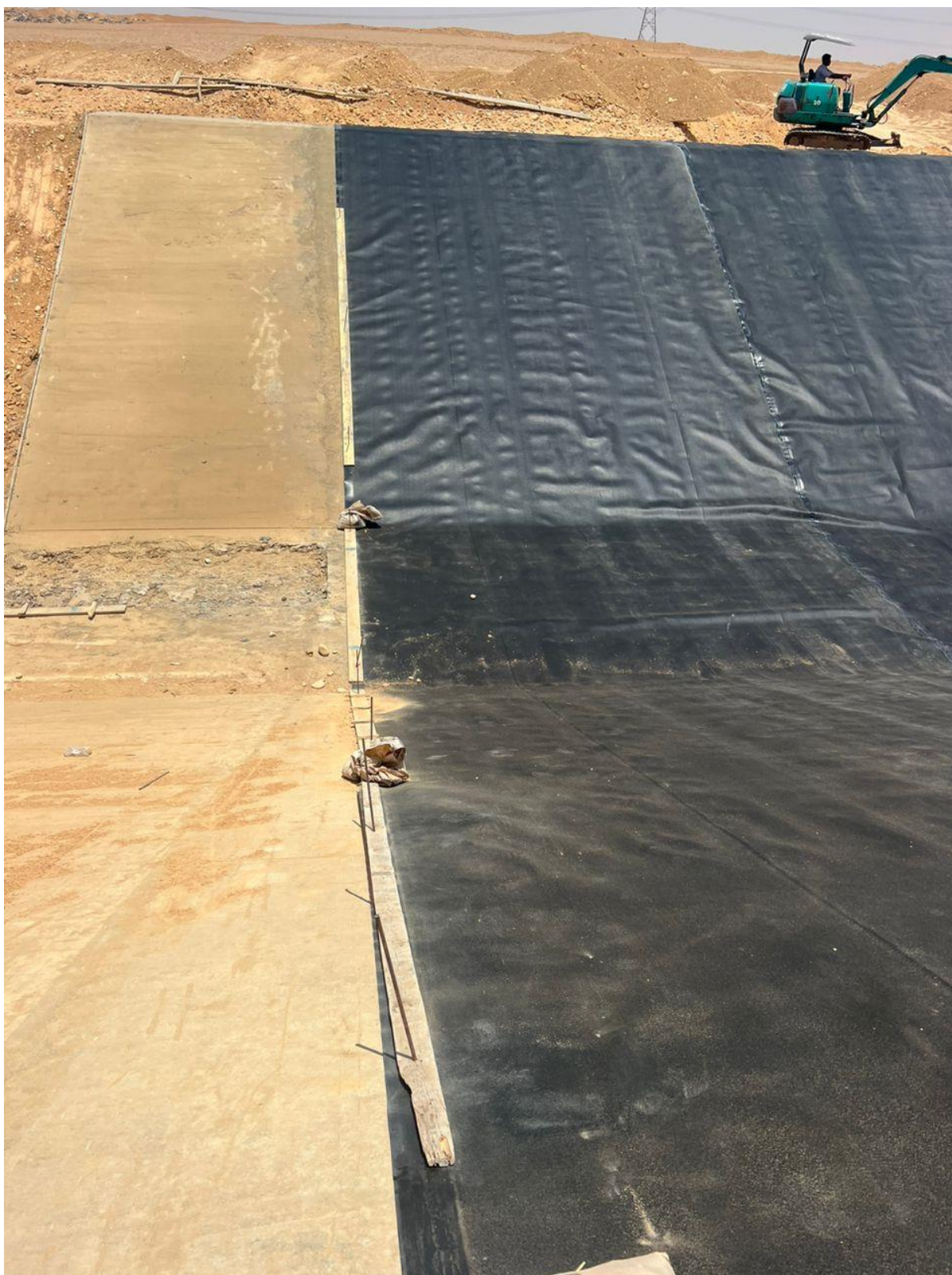
أعمال إنشاء الترعر الناقله للمياه العكره - محافظه بنى سويف
