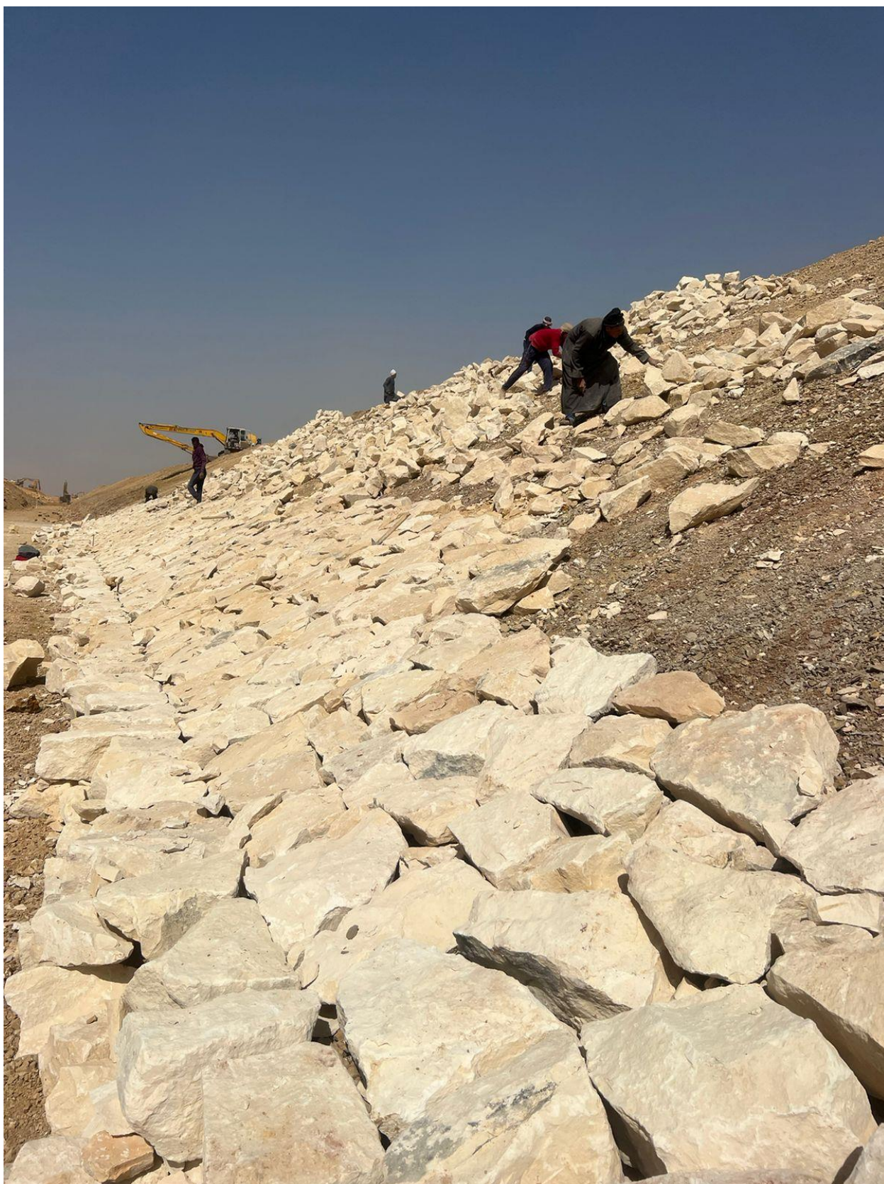
أعمال إنشاء الترعر الناقله للمياه العكرة - محافظة بنى سويف
