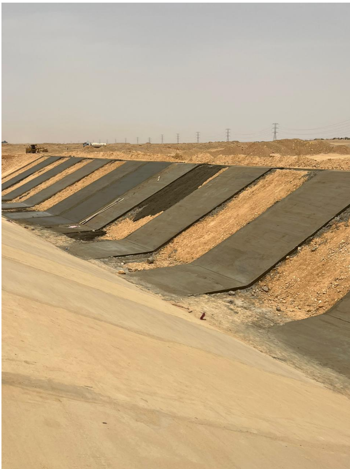
أعمال انشاء الترعر الناقله للمياه العكرة - محافظة بنى سويف
