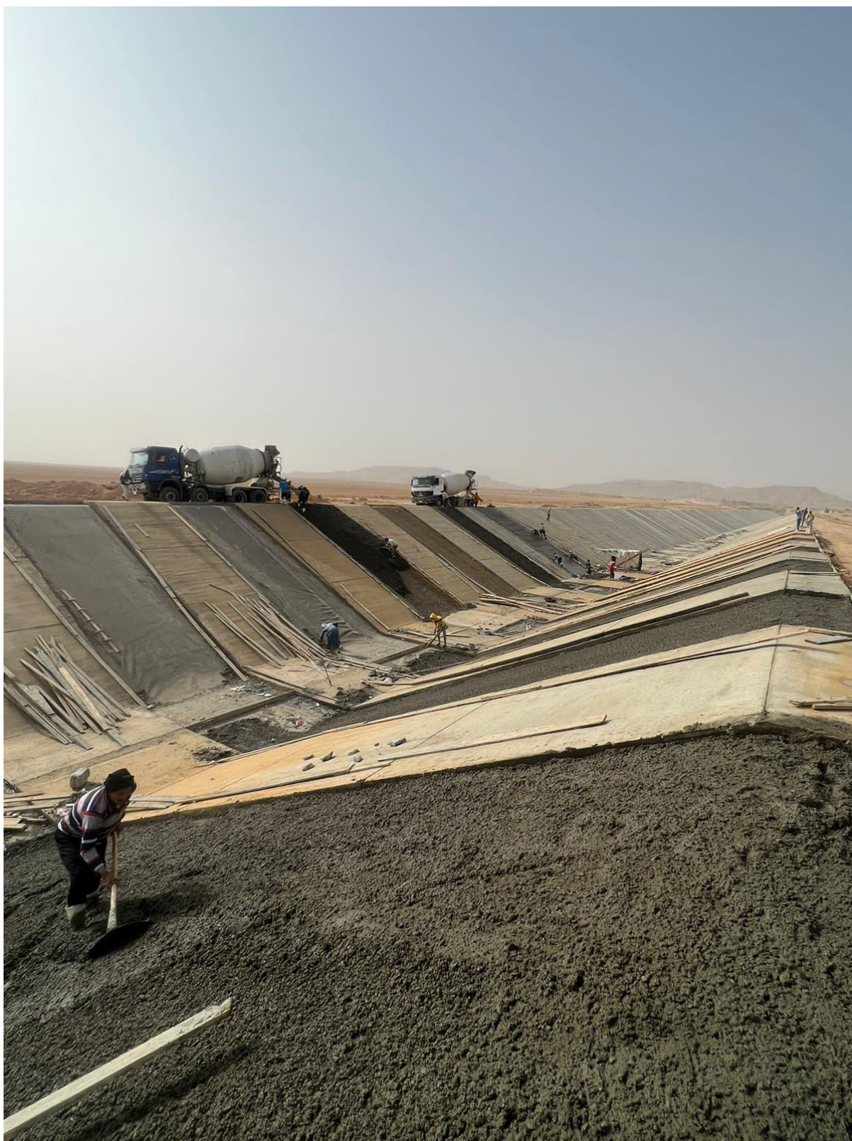
أعمال انشاء الترع الناقلة للمياه العكرة - محافظة بنى سويف
