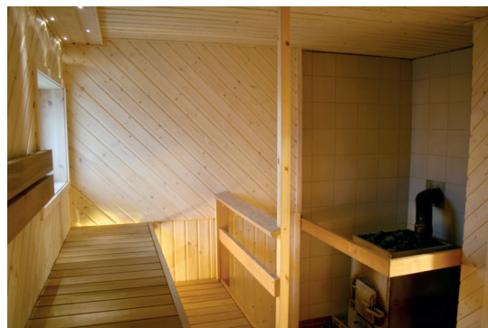
Vanha sauna remontoituna
