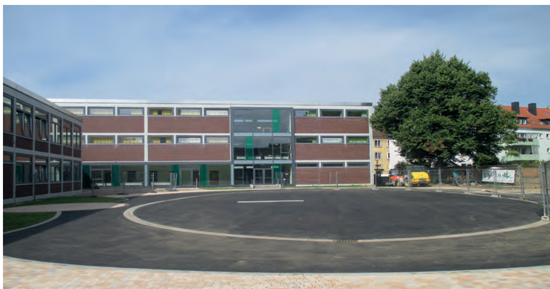
Die Bauarbeiten schreiten voran - Noch in diesem Jahr wird der Spielhof fertiggestellt werden
