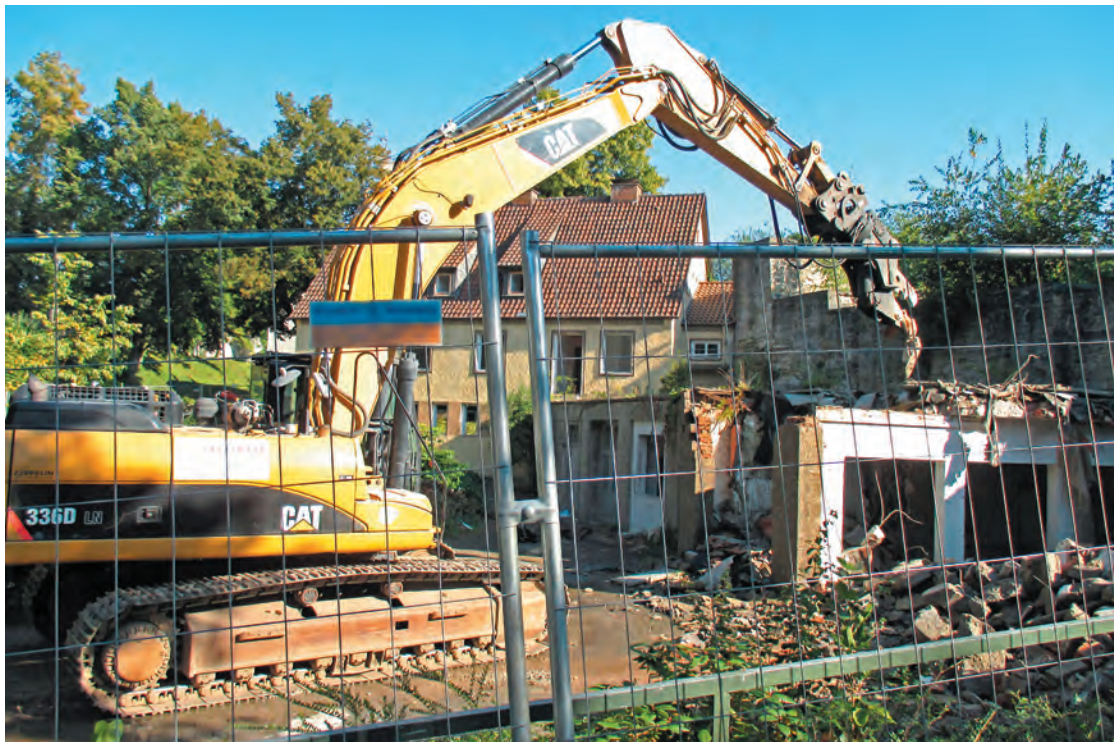
Beginn der Abrissarbeiten: Der Bagger arbeitet sich von den Garagen bis zum Gebäude vor
