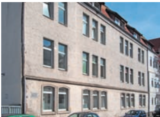
Bestand Gebäude Michaelisstraße 53–54
