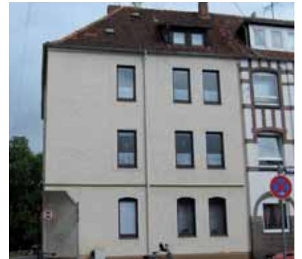
Gebäude vor der Sanierung
