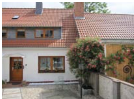
Blick auf die Hoffläche vor dem Hinterhaus
