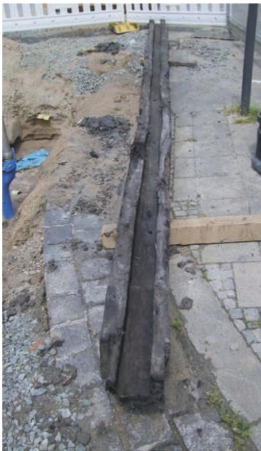
Eine besondere Holzwasserleitung aus der Langen Burgstraße. Der Wasserdurchlauf ist viereckig mit einem Holzdeckel. - Foto: Karl Scheide
