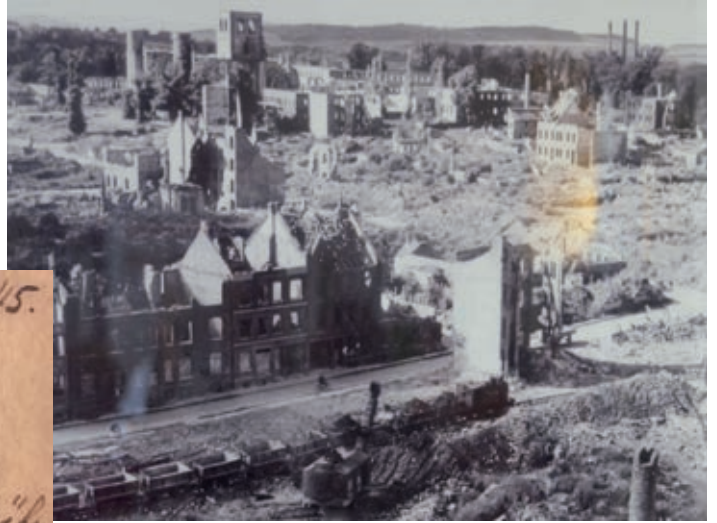
Blick auf das zerstörte Michaelisquartier Bildnachweis: Archiv Verlag Gebrüder Gerstenberg (Wetterau)
